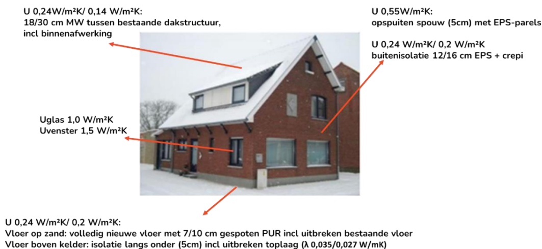
Figuur 4: Verschillende isolatiemaatregelen van de typewoning
